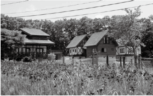
写真2 カサラファームのレストラン・管理棟(左)。右は宿泊棟
